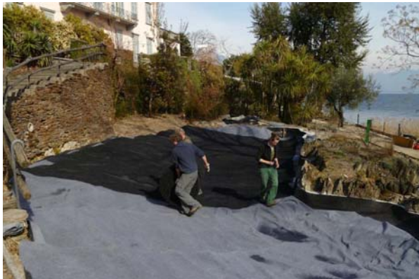
Abb. 5: Das synthetische netzartige Gewebe wird ausgelegt um ein Abrutschen des Kieses zu verhindern. Foto: Luca Bacciarini
