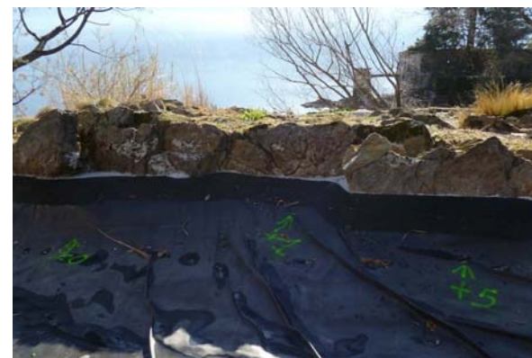
Abb. 4: Wie an dieser Stelle wurde die Teichfolie zum Teil direkt an den Felsen fixiert. Foto: Luca Bacciarini
