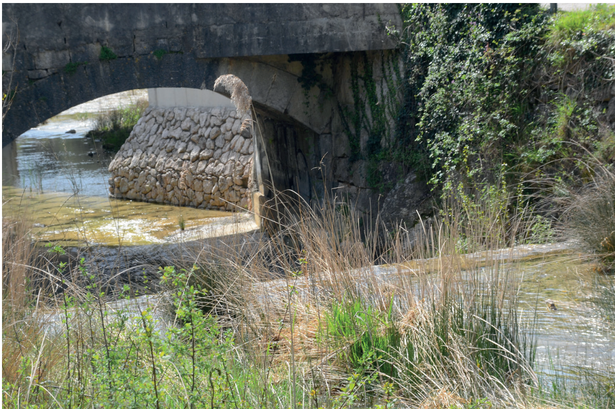
Abb. 24: Brücke über den Vela Rika bei Jurandvor.
