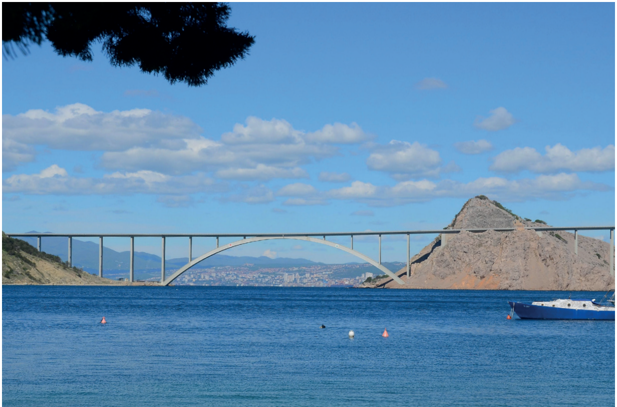
Abb. 1: Der Blick vom Norden Krks, von der Baustelle für die neue Brücke, auf Rijeka. Im Vordergrund die vorhandene Brücke.
